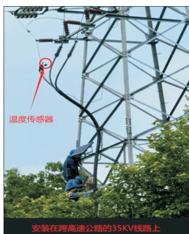
安装在跨高速公路的35KV线路上
