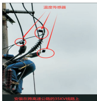
安装在跨高速公路的35KV线路上
