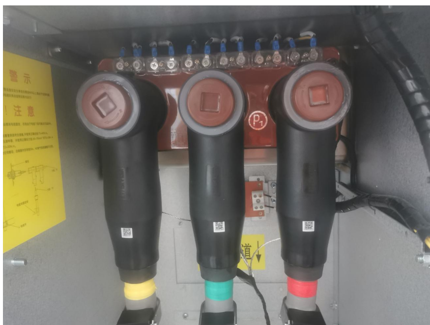
安装带温度传感的绝缘塞器之后
