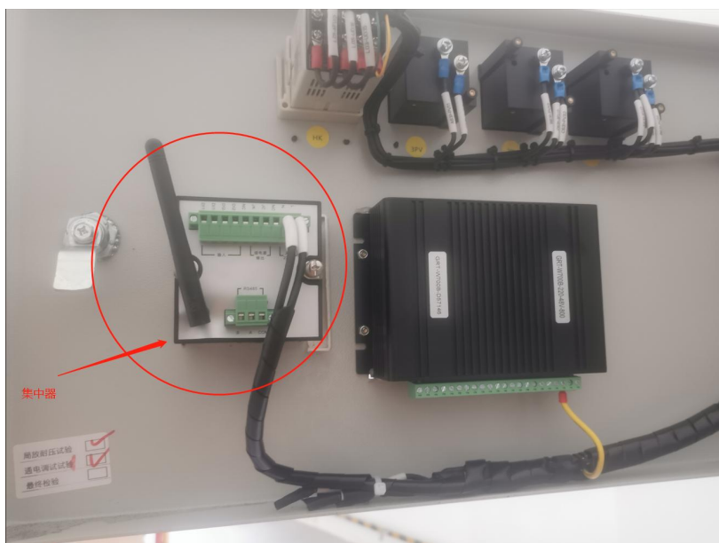
安装好的无线温度采集器背面
