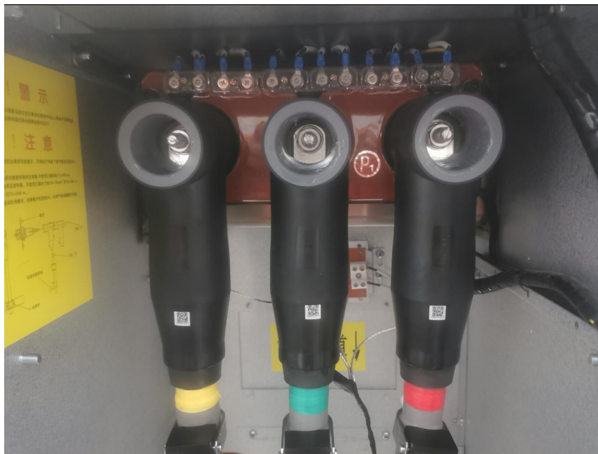
安装带温度传感的绝缘塞器之前
