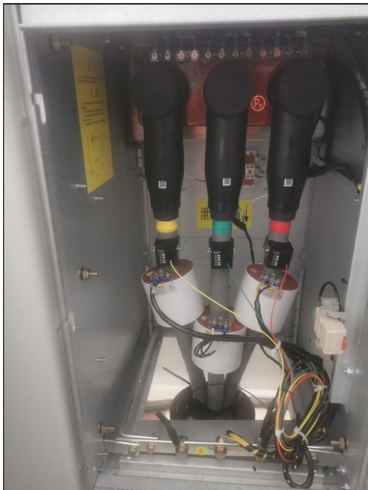
安装好带温度传感的绝缘塞器、后盖之后
