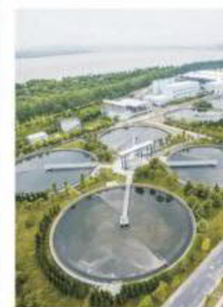
污水厂、水厂项目 Sewage plant, water plant project
